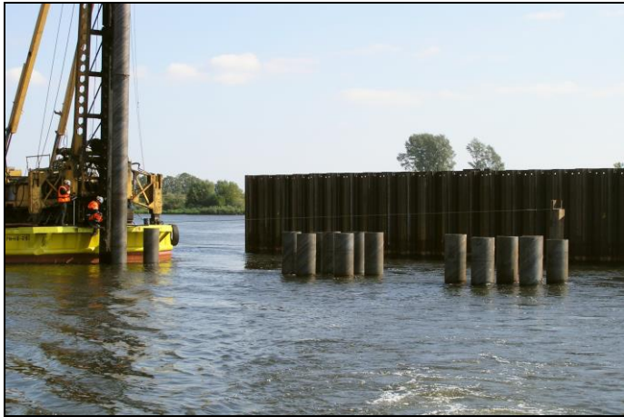
Rys. 10. Pale rurowe podpory tymczasowej mostu w Grudziądzu. W tle widoczna ścianka szczelna osłaniająca podporę stałą mostu
