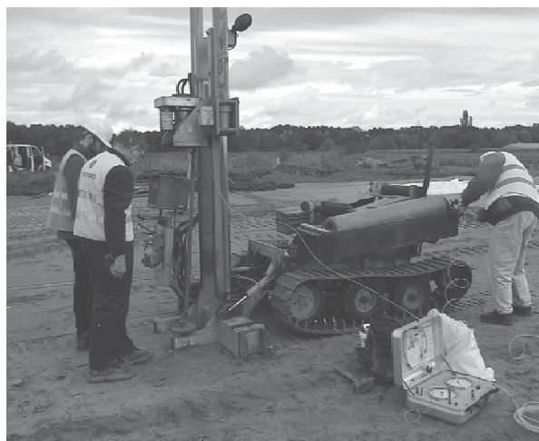
Rys. 2. Badania dylatometryczne na platformie roboczej
