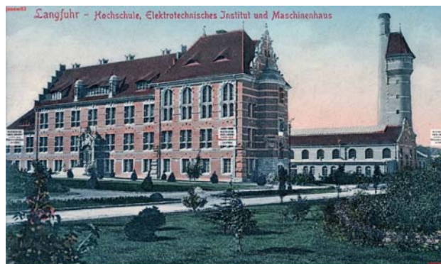
Rys. 1. Budynek Instytutu Elektrotechnicznego, na drugim planie Laboratorium Maszynowe z kominem i zbiornikiem wody. Źródło: www.google.com
