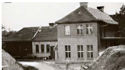
Rys. 13. Budynki w Gródku, w których mieściły się laboratorium wysokich napięć oraz laboratorium olejowe [11]
