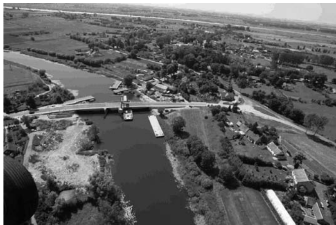
Rys. 5. Most w Drewnicy „z lotu ptaka”
