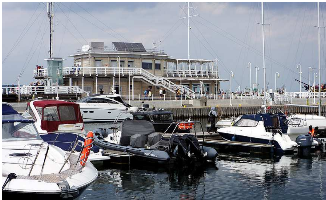
Fot. 116. Budynek mieszczący zaplecze biurowe, socjalne, gospodarcze i restaurację. Fot. Katarzyna Rembarz (01.06.2019)
