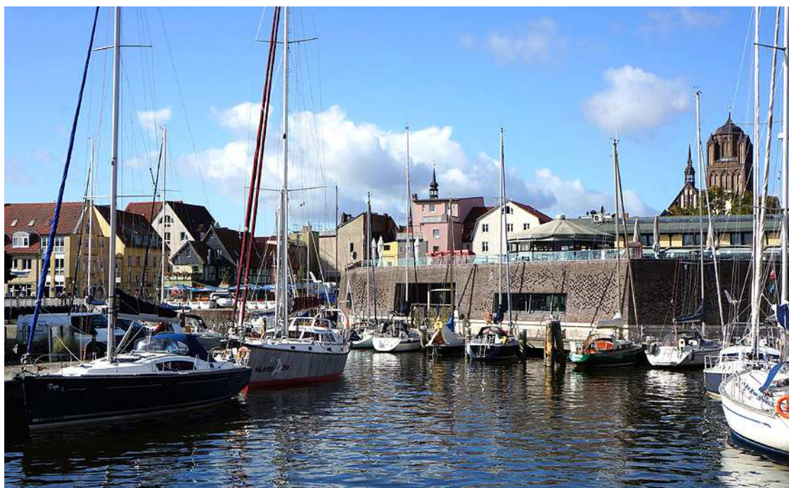
Fot. 31. Stralsund – Bastion Kron-Lastadie po przebudowie. Fot. Katarzyna Rembarz (13.09.2018)
