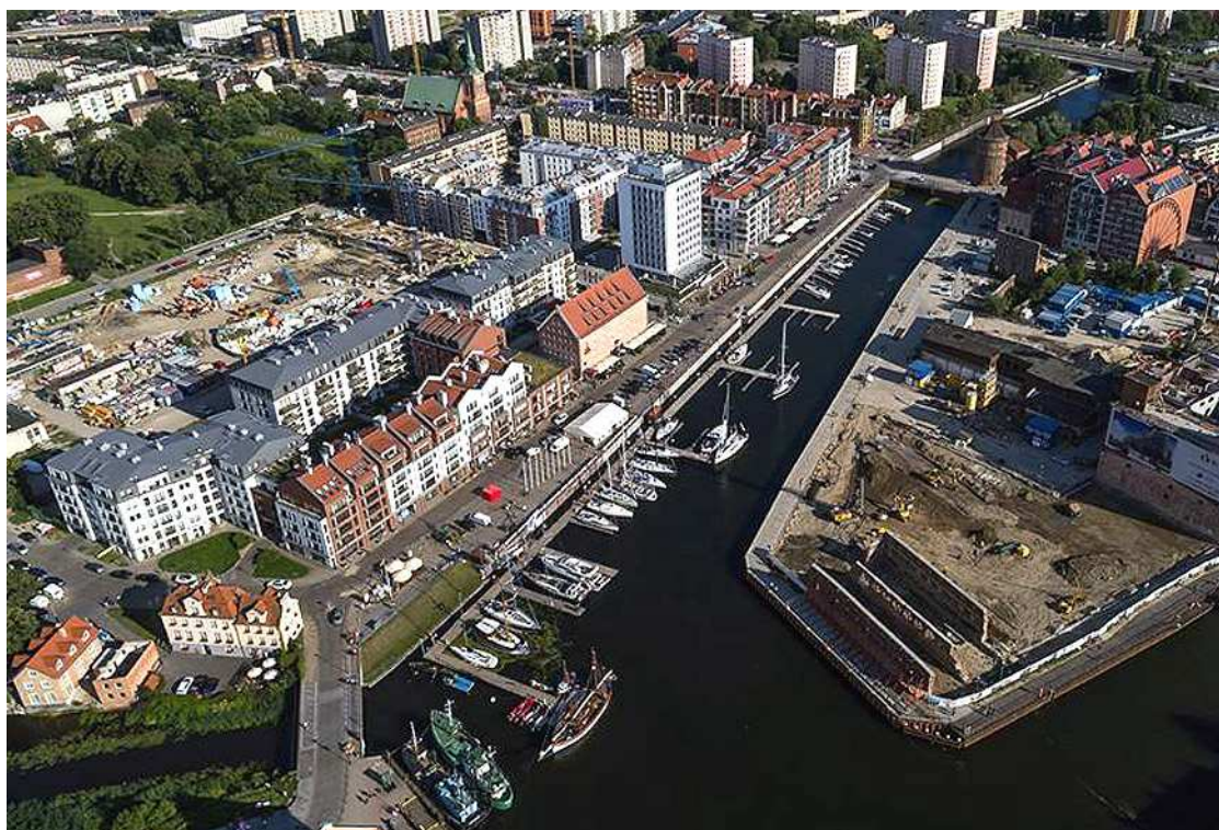
Fot. 120. Gdańsk – przystań na Szafarni.
