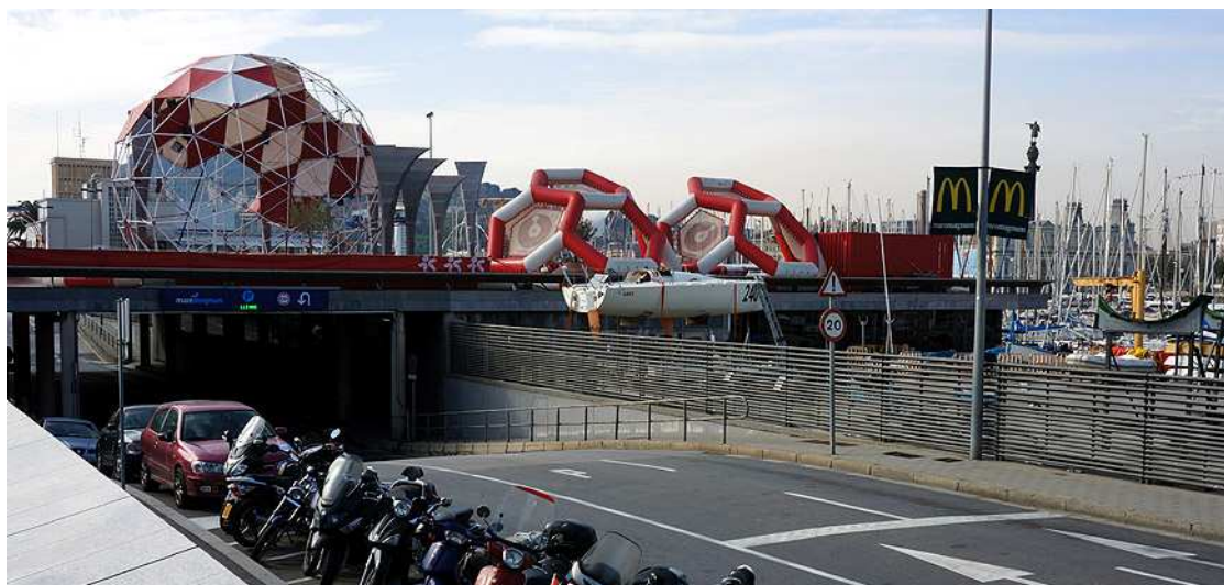
Fot. 59. Kładka nad ulicą łącząca plac miejski z dachem nad hangarem. Fot. Katarzyna Rembarz (12.02.2015)
