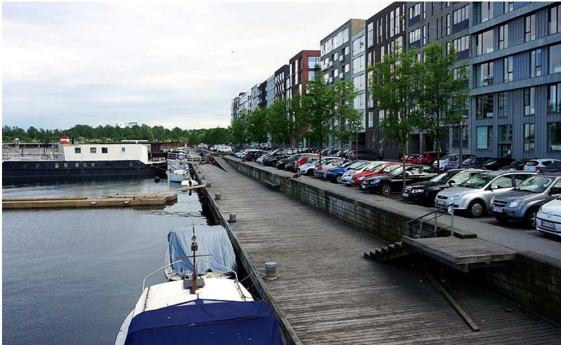
Fot. 81. Sluseholmen – dawny kanał portowy (Teglværksløbet) i nowa zabudowa. Widoczne nowe pomosty dla jednostek pływających. Fot. Katarzyna Rembarz (26.05.2016)
