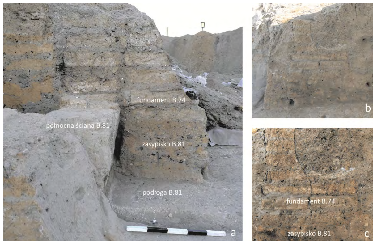
Rycina 67. Północno-zachodni narożnik budynku B.74-B.62/B.61: a) widok od strony zachodniej – widoczne posadowienie północnej ściany domu B.74-B.62/B.61 na relikcie północnego muru budynku B.81 (fot.: M.Z. Barański), b-c) widok od strony południowej ilustrujący posadowienie prostego muru na fundamencie złożonym (fot. J. Quinlan).
