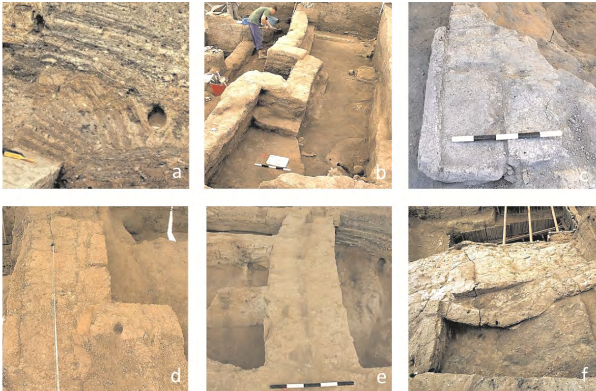
Rycina 112. Przykłady zniszczeń i deformacji obiektów murowanych: a) zawalony fragment ściany budynku B.132 w North Area (fot. J. Quinlan), b) przechylenie się ściany budynku B.103 w TP Area (fot. A. Leszczewicz), c) zgniecenie narożnika budynku B.109 w TPC Area (fot. A. Mickel), d) pęknięcie podłużne fundamentu budynku B.95 w TP Area (fot. A. Leszczewicz), e) wygięcie muru budynku B.52 w North Area (fot. J. Quinlan), f) wygięcie i skręcenie mur budynku B.104 w South Area (fot. J. Quinlan).
