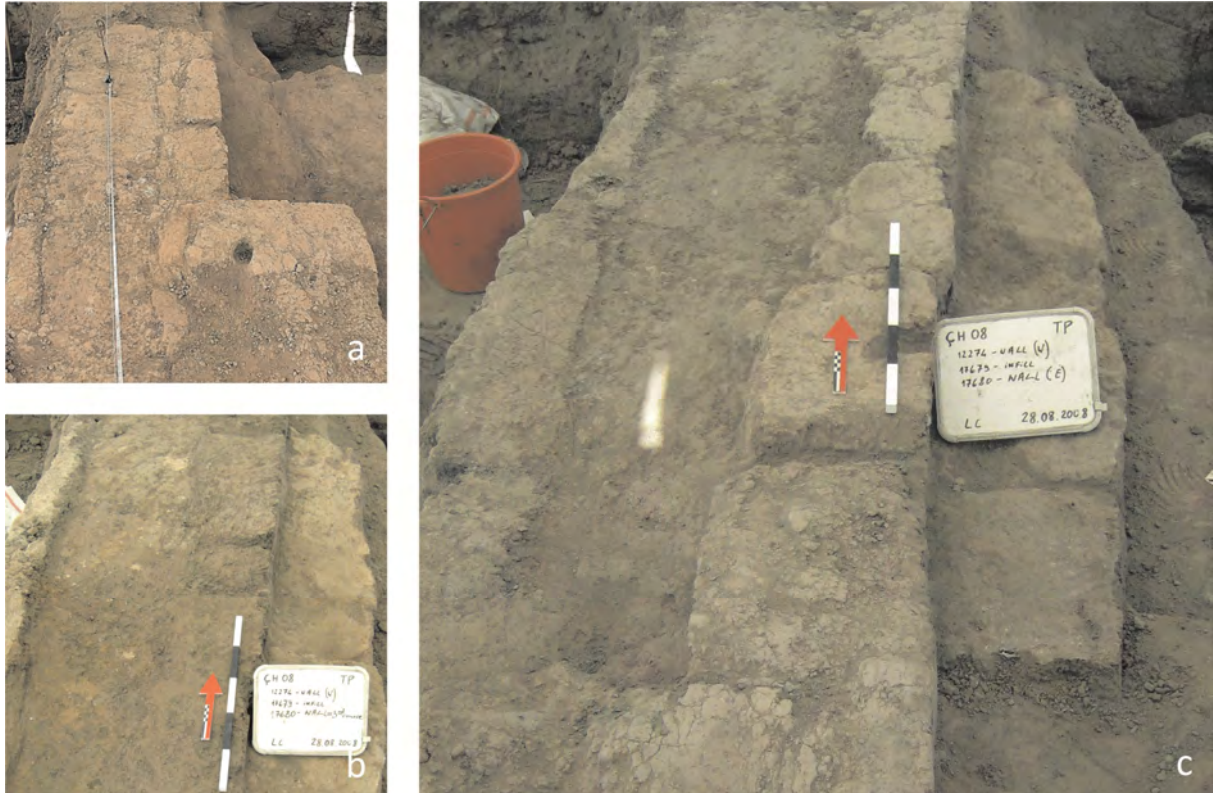
Rycina 32. Pęknięcie podłużne wschodniego fundamentu (F.2873/F.3161) budynku B.95 (fot. A. Leszczewicz).
