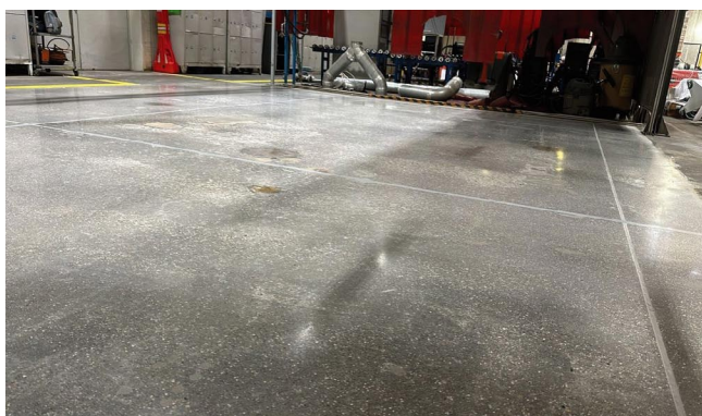
Rys. 8. Betonowa posadzka przemysłowa (przykład 1) po naprawie: widok ogólny oraz widoczne odtworzone i uzupełnione dylatacje skurczowe
