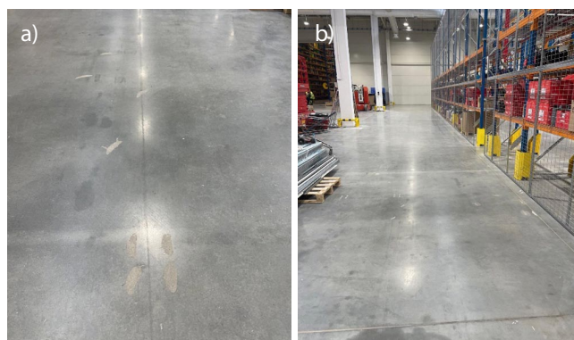
Rys. 15. Betonowa posadzka przemysłowa (przykład 2) po naprawie: a) widoczne miejsca wypraw po wycięciu kotew, b) widok ogólny posadzki po naprawie
