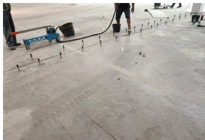
Rys. 11. Betonowa posadzka przemysłowa (przykład 2) podczas naprawy: montaż pakerów i podawanie iniektu cementowego za pomocą pompy
