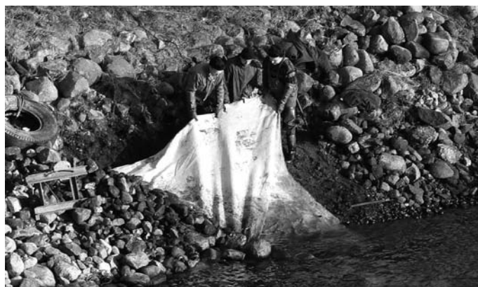
Rys. 9. Układanie geowłókniny na skarpi
