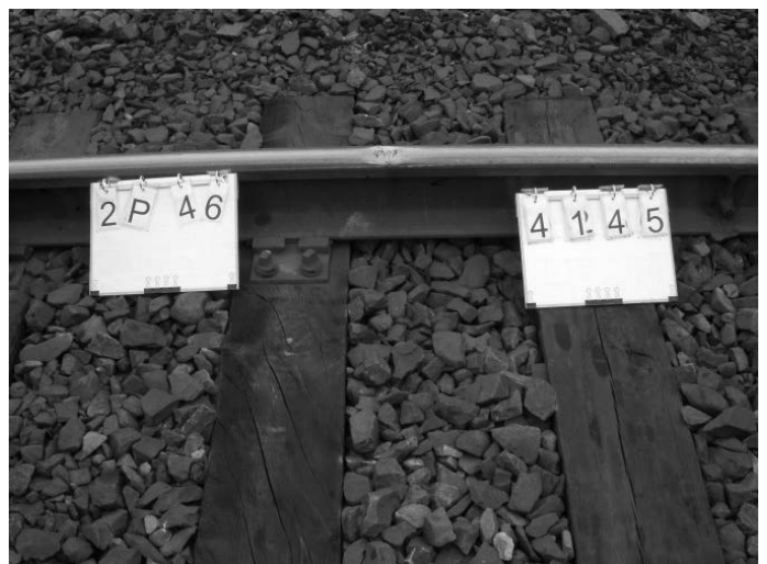
Rys. 8. Wada squat – brak przytwierdzenia szyny do podkładu
