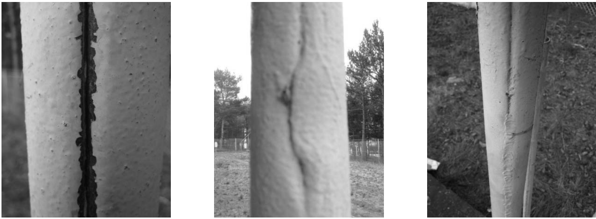
Rys. 7. Rura w miejscu szwu podłużnego
