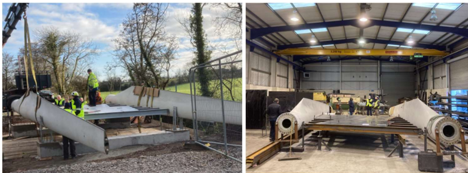
Rys. 5. Kładka dla pieszych wykonana na podstawie koncepcji Re-Wind Network [22]
