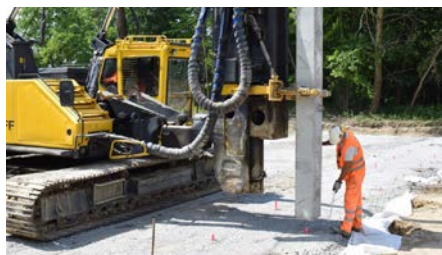
Fot. 2. Platforma robocza z tłucznia na geotkaninie [Aarsleff Sp. z o.o.]
