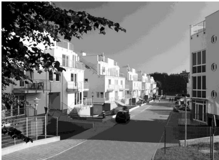
Fot. 2. Zespół zabudowy mieszkaniowej w Gdyni Orłowice
