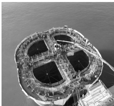
Rys. 7. Widok czterokomorowej konstrukcji skrzyni w czasie budowy, Tanger (Maroko)
