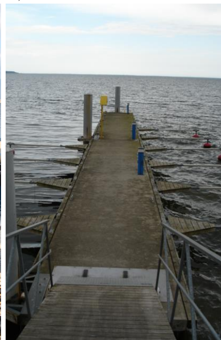
Rys.1. Przykładowe rozwiązania pomostów pływających a) na pływakach z tworzywa sztucznego, b) na pontonach siatkobetonowych
