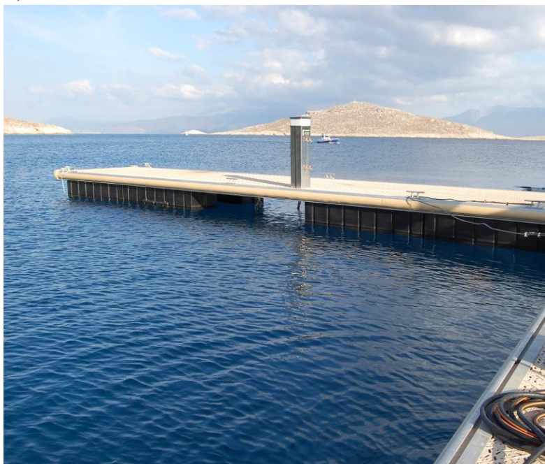
Rys.1. Przykładowe rozwiązania pomostów pływających a) na pływakach z tworzywa sztucznego, b) na pontonach siatkobetonowych
