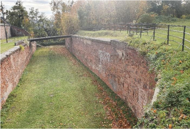
Photo. 1: Widok ogólny szańca obronnego przylegającego do Zespołu Budynków
