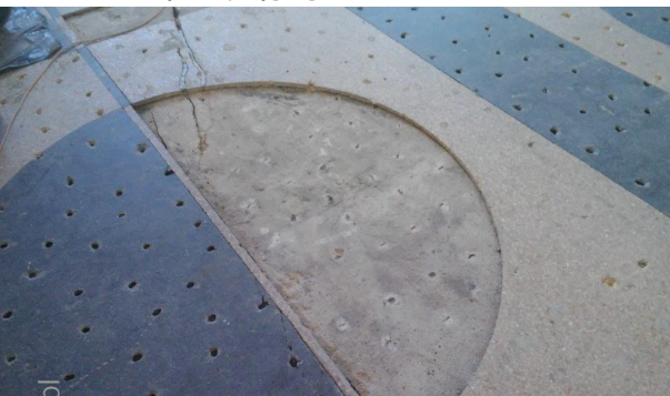
Fot. 3. Różnicowanie kolorystyczne oraz geometryczne naprawianej posadzki lastrico, widoczne fragmenty wymienianej i regenerowanej posadzki [M1]
