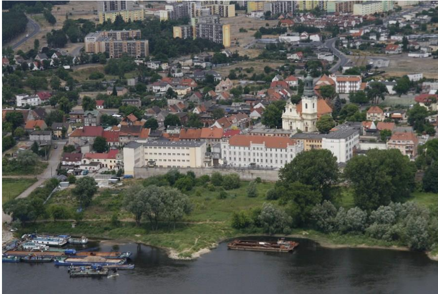
Ryc. III. 7. Kompleks obecnego więzienia (dawniej komora celna). Przeskalowana rozbudowa więzienia niszczy trójplanową panoramę, InfoFordon.
