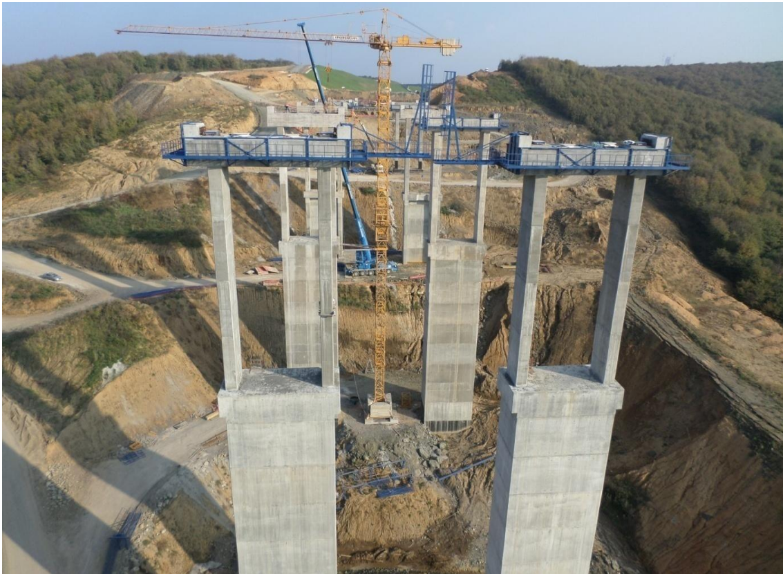
Rys. 38 Zdjęcie z budowy wiaduktu V17 (wrzesień 2014)
