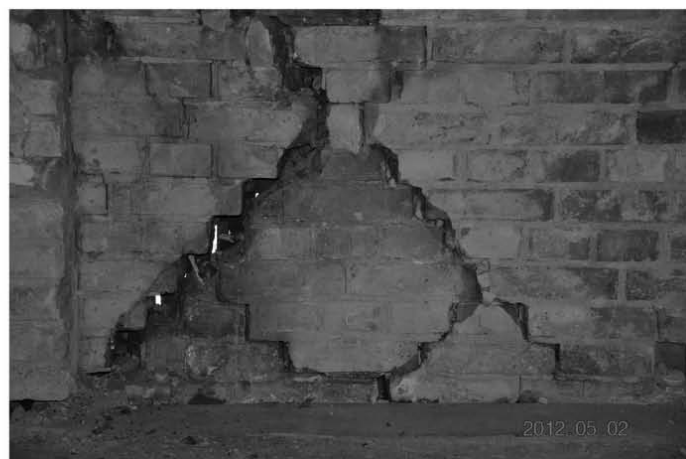
Rys. 2. Uszkodzenia murów (widok od strony wnętrza budynku oraz widok od strony elewacji zewnętrznych)
