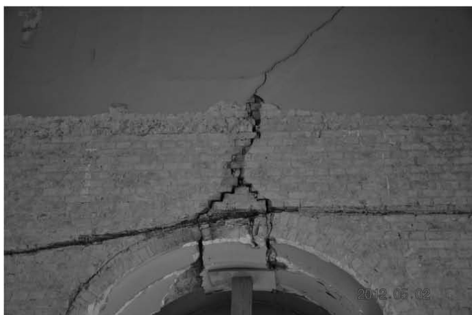
Rys. 2. Uszkodzenia murów (widok od strony wnętrza budynku oraz widok od strony elewacji zewnętrznych)
