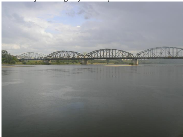
c) most kolejowo-drogowy Grudziądz
