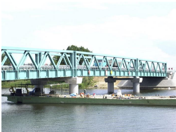
Rys. 5. Most w Kępkach na Nogacie (prześwit zaledwie 330 cm nad WWŻ), (fot. P. Salecki)
