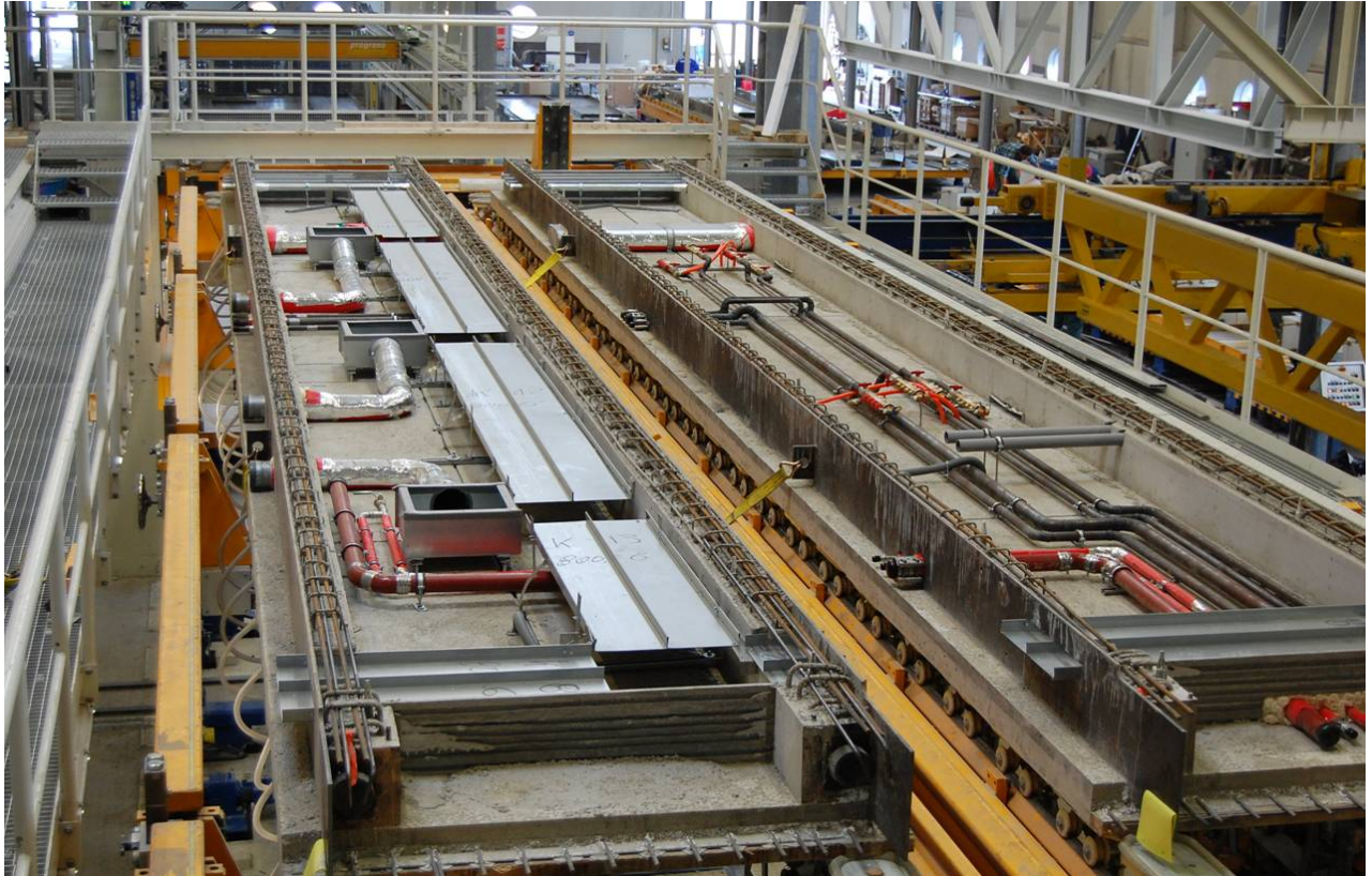
Bild 2: Im Hohlraum der Sandwichdecke verlegte Installationsleitungen
