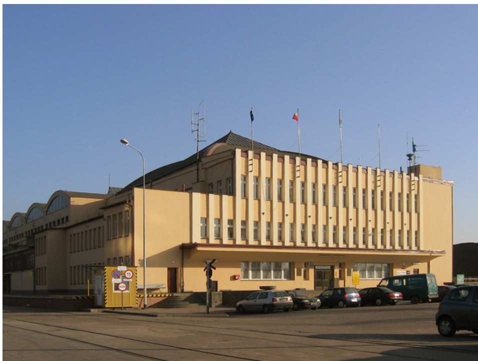
Ryc. 2 Gdynia. Dworzec Morski, narożnik północno-zachodni zniszczony w czasie wojny i nieodbudowany w pełnej wysokości, 2015 r., fot. R. Hirsch
