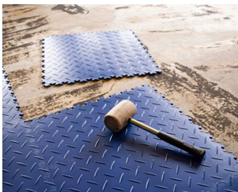
Rys. 3.1. Posadzka przemysłowa z okładziną z tworzywa sztucznego (fot. www.fortelock.pl )
