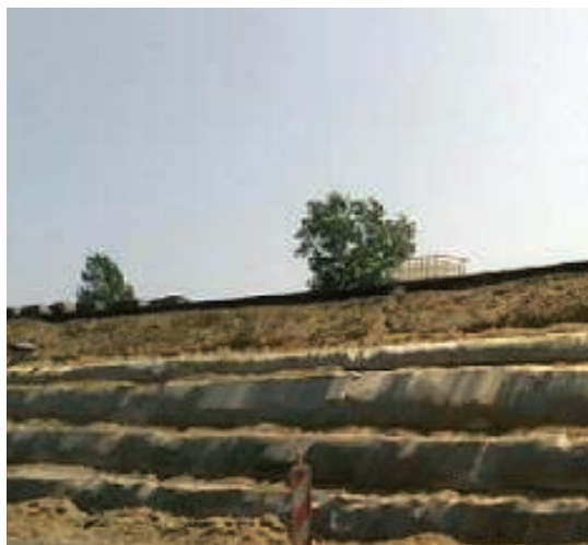
1. Wielowarstwowe ułożenie geosyntetyków w nasypie
