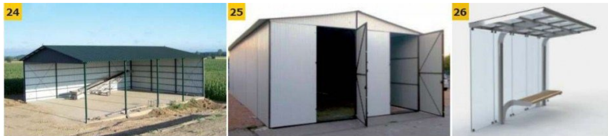
FOT. 24-26. Przykłady zastosowania przegród jednowarstwowych: wiata rolnicza (24), garaż (25), wiata przystankowa (26). Fot. Kelmet, Fulco System
