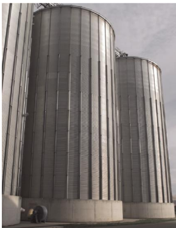
Rys. 5.2: Silosy cylindryczne o ścianach z blachy falistej z pionowymi słupami o zmiennej grubości blachy falistej z zmiennymi przekrojami słupów: a) silos S600 (wysokość H = 17,62 m i średnica D = 5,35 m) [20], b) silos S900 (wysokość H = 17,62 m i średnica D = 8,02 m) (rozdział 4.6) oraz c) silos S1600 (wysokość H = 17,62 m i średnica D = 15,15 m).
