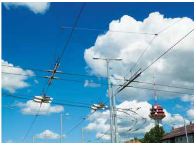
Fot. 3. Szybkoprzejezdne skrzyżowanie trolejbusowej i tramwajowej sieci trakcyjnej, Szeged, Węgry. Fot. M. Bartłomiejczyk
