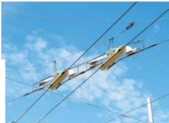
Fot. 2. Szybkoprzejezdne skrzyżowanie trolejbusowej i tramwajowej sieci trakcyjnej, Ostrava, Republika Czeska. Fot. M. Bartłomiejczyk
