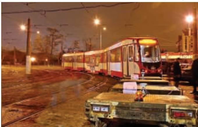
1. Zestaw pomiarowy w mobilnych pomiarach satelitarnych układu geometrycznego torów tramwajowych [14] - fot. Jacek Szmagliński
