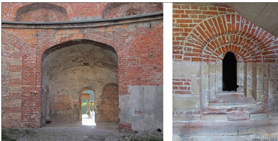
Ryc. 7. Zachowane oryginalne elementy Wieńca: strzelnica – widok od zewnątrz, otwarta kazamata – obecne wejście; fot. R. Hirsch. Fig. 7. The surviving original elements of the Wreath: the battery emplacement – external view, open casemate – the present entrance; photo by R. Hirsch.
