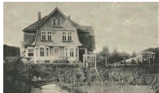
il. 94. Willa przy ul. Polanki 116, nieistniejąca. Kompozycja elewacji szczytowej oraz cechy bryły wykazują duże podobieństwo do projektu z il. 93.
