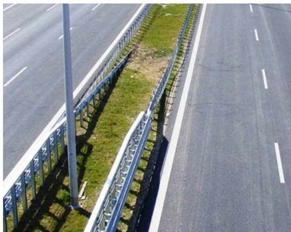
Fot. 1. Odcinki przejściowe barier ochronnych na Obwodnicy Południowej Warszawy [9]
