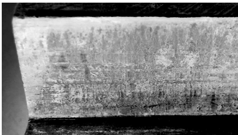
Rys. 9.9 Uszkodzenie powierzchni prowadnicy wykonanej ze stali S355 na skutek zbyt dużych nacisków powierzchniowych przy wzajemnym ruchu elementów
