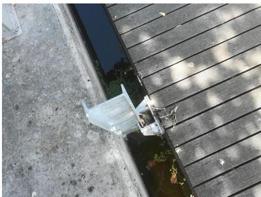
Rys. 3.63. Kotwiczenie z zastosowaniem suwaka. (Miszevska, 2018)
