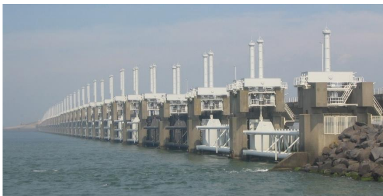
Rys. 3.4. Zapora przeciwpowodziowa Oosterscheldekering na Skaldzie Wschodniej w prowincji Zelandia. (Šiman, 2008)
