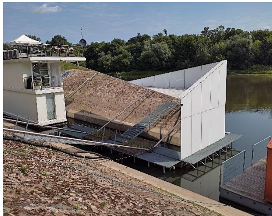
Rys. 3.51. Dom pływający – obiekt 2, kanał Czerniakowski, Warszawa. (Miszevska, 2021)
