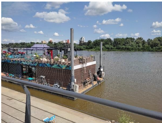
Rys. 3.67. Pale opuszczane na dno, podczas przemieszczania kładzone na specjalnych łożach, Bulwary Wiślane, Warszawa. (Miszewska, 2021)
