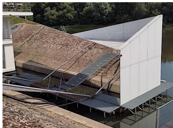
Rys. 3.28. Port Czerniakowski – Domy Na Wodzie – widok 2. (Miszevska, 2021)
