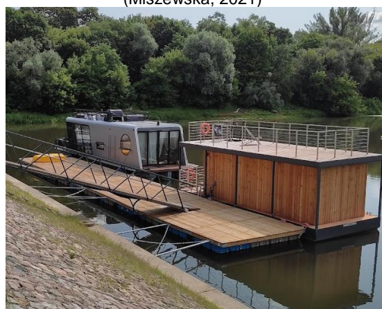
Rys. 3.30. Port Czerniakowski – Domy Na Wodzie – widok 4. (Miszevska, 2021)
