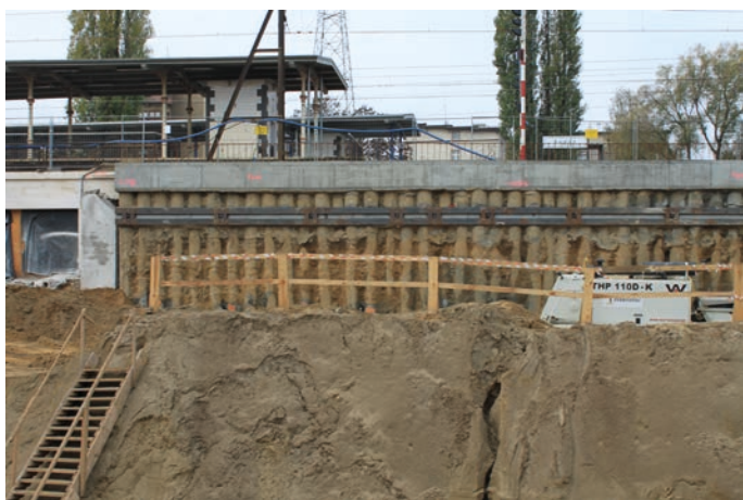
Rys. 6. Budowa Nowego Centrum Sopotu. Wykop – I faza
