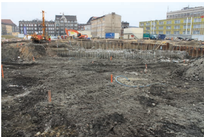
Rys. 8. Budowa ECS w Gdańsku. Widok wykopu – widoczne żelbetowe elementy do usunięcia oraz sondy gruntowych pomp ciepła
