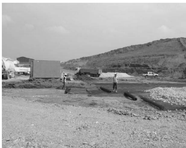
Rys. 5. Układanie warstw wzmacniających platformę [4]
