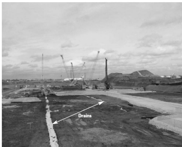
Rys. 3. Ochrona podłoża przez odpowiedni drenaż [4]
