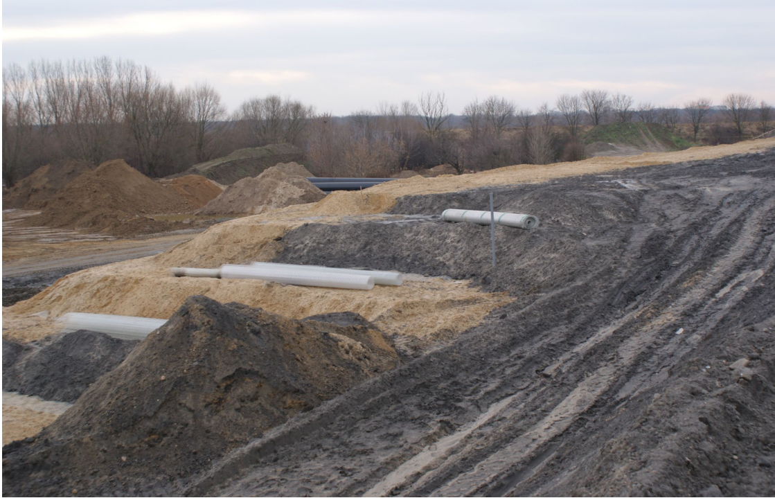
Zdjęcie 4. Fragment wykonanego nasypu. Widoczne fragmenty wykonane z samego piasku (skarpy) oraz mieszanka z UPS.
