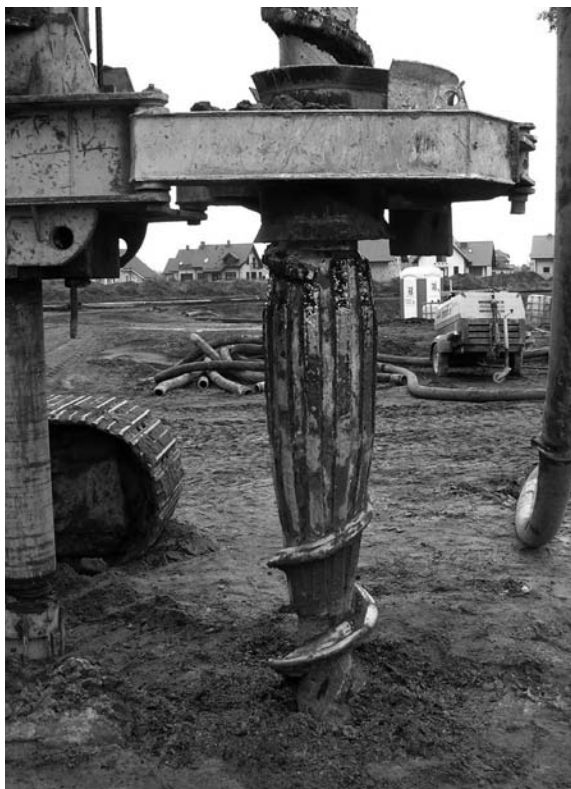
Rys. 16. Poletko Pruszcz - świder SDP \phi 360 mm
