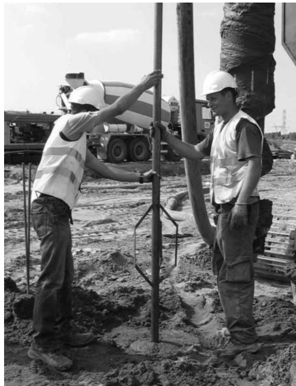
Rys. 3. Wprowadzanie rurki do instalowania łańcucha czujników strunowych
