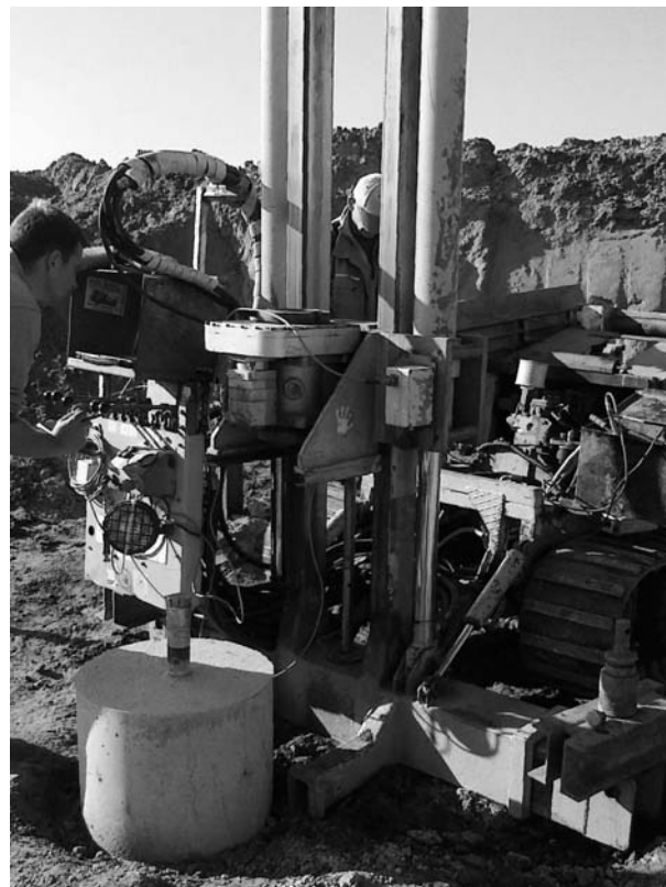
Rys. 2. Sondowanie CPTU obok wykonanego pala w odległości 60 cm od osi pala
