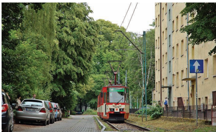
5. Stan toru oraz przeszkody terenowe na odcinku d
