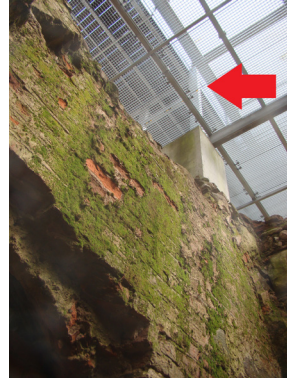
Ryc. 2 Eksponowany we wnętrzu mur przyziemia skrzydła północnego. Widoczne wnęki lunet i żelbetowy strop (2018, fot. autora)
