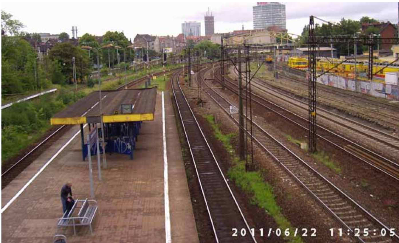
1. Przykład fotografii orientacyjnej – widoczny peron, słupy trakcyjne, tory i inne elementy ułatwiające orientację w terenie – zdjęcie wykonane z kładki dla pieszych
