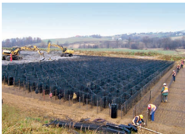
Fot. 2. Konstrukcja geomateraca
