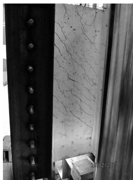
Rys. 12. Szczegół zarysowania wspornika tarczy DB-II
