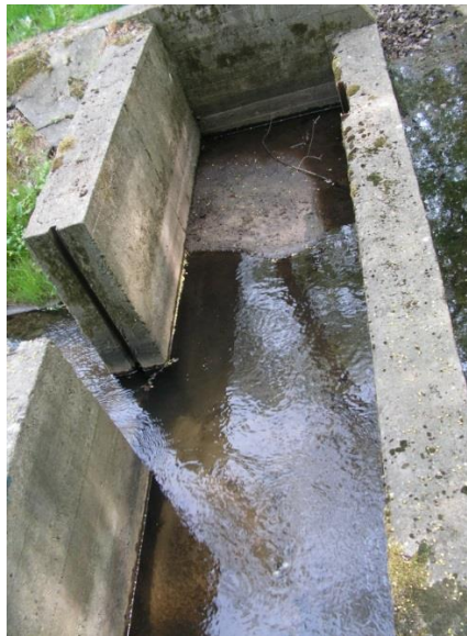
Rys. 3.8. Piaskownik (fot. Marzena Stosik)
