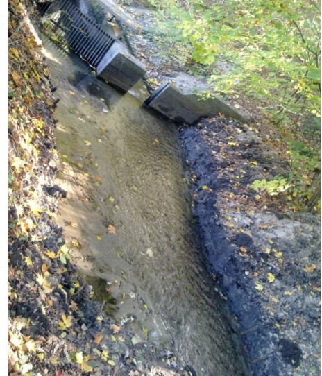
Rys. 3.7. Krata: a) widok z góry, b) dopływ potoku Swelina do piaskownika przez kratę (fot. Marzena Stosik)
