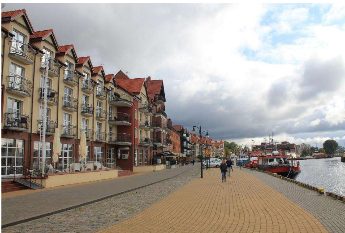
Ryc. 100 Wschodnie nabrzeże rzeki Słupia, Ustka, przekształcone tereny poportowe (fot. M. Izydor)
