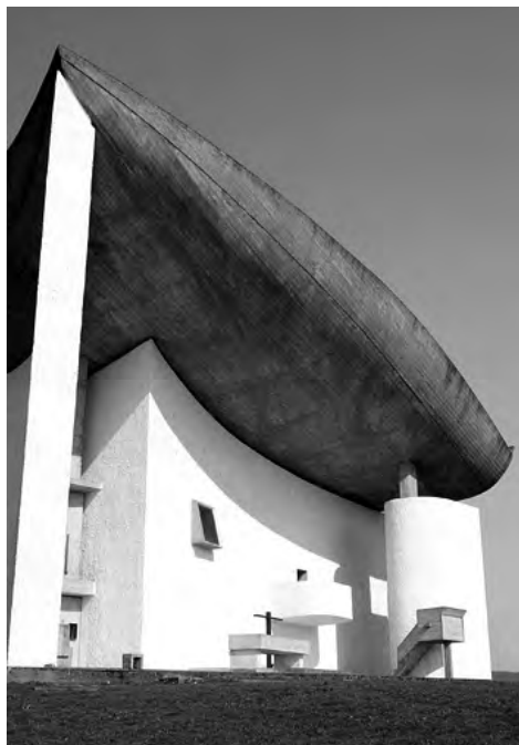
206. Le Corbusier, kaplica w Ronchamp, dach, 1950–1954
