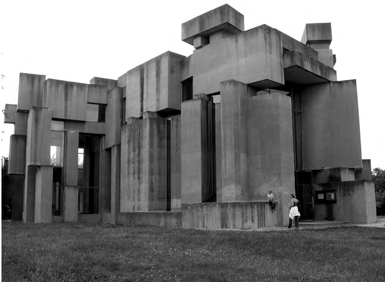
227. Fritz Wotruba, kościół Trójcy Świętej, 1974–1976, Wiedeń
