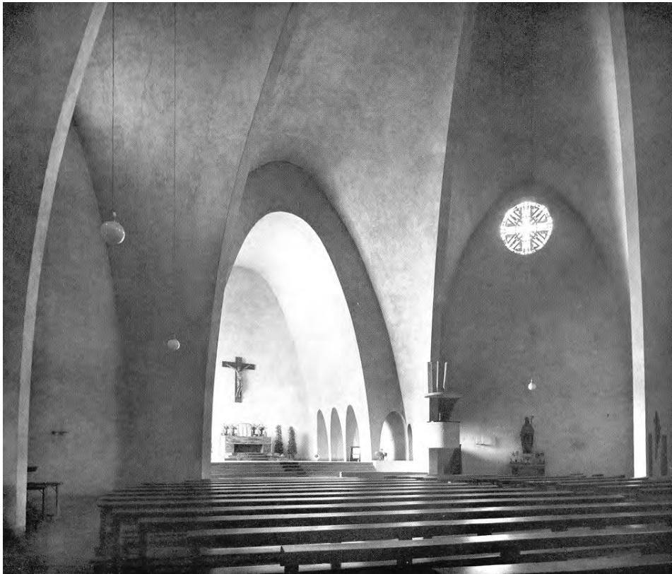
49. Dominikus Böhm, kościół św. Engelberta, 1930, Kolonia
