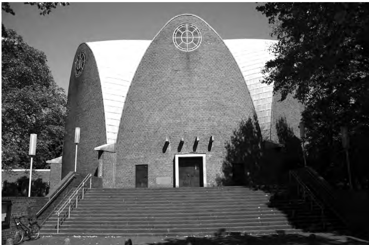
48. Dominikus Böhm, kościół św. Engelberta, 1930, Kolonia
