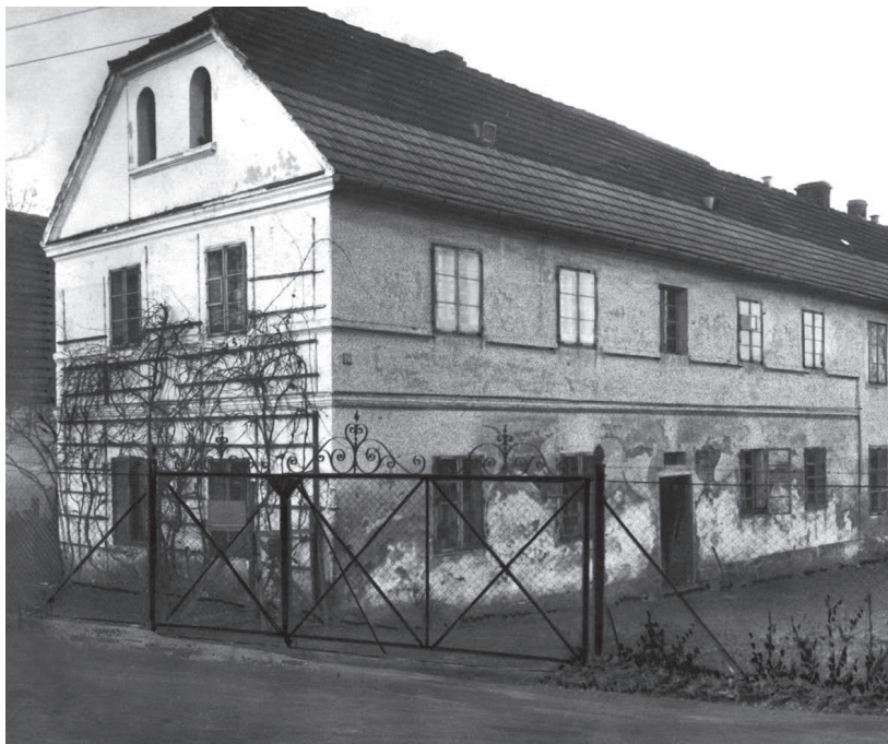
Fot. 1. Istniejący do dzisiaj dom przy ul. Stawowej 10 w Ziębicach
