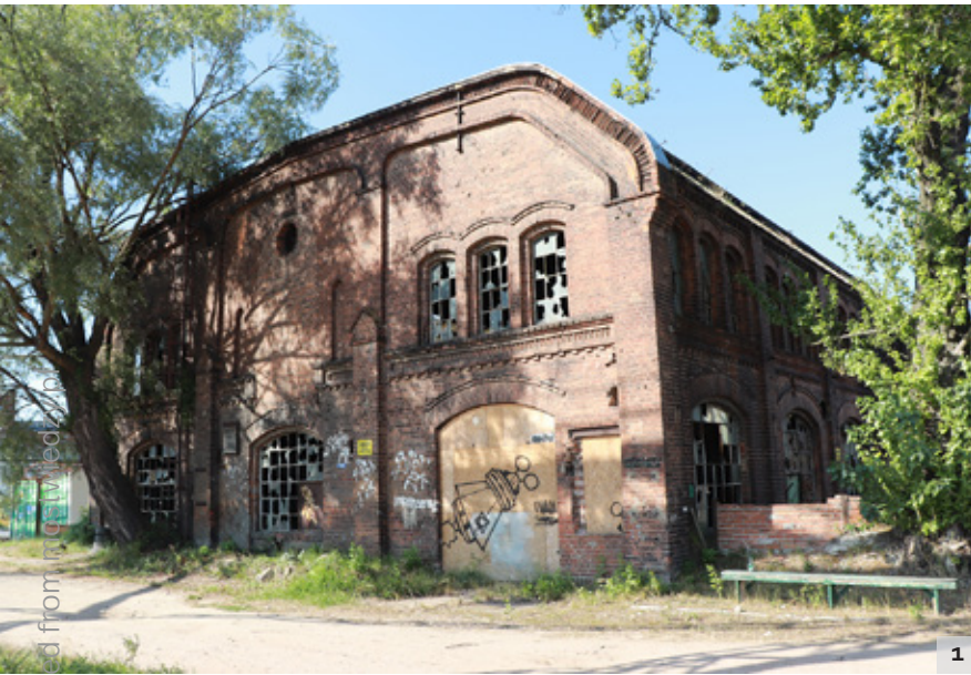
Fot. 1. Historyczny budynek Formierni
