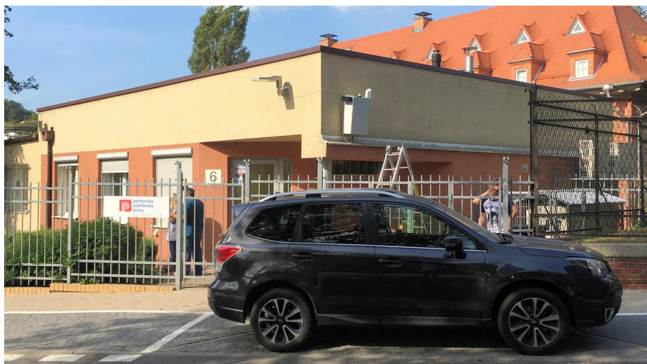
Rys. 56. Miejsce instalacji szafy badaniowej - widok od strony jezdni, ul. Traugutta.
