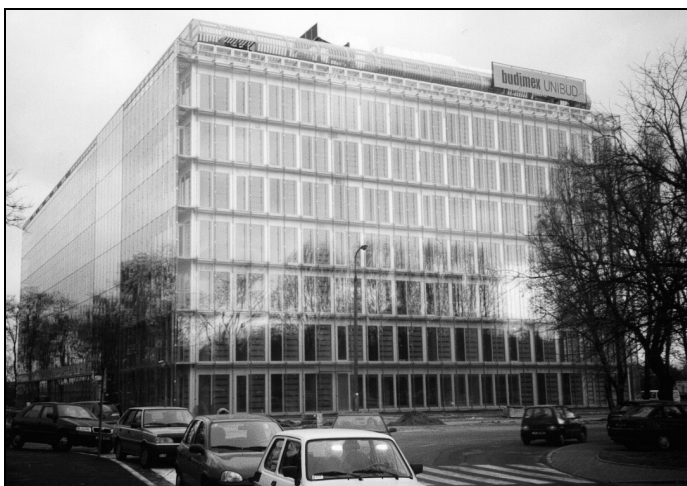
Rys. 10 Widok budynku PLL LOT (październik 2001)
